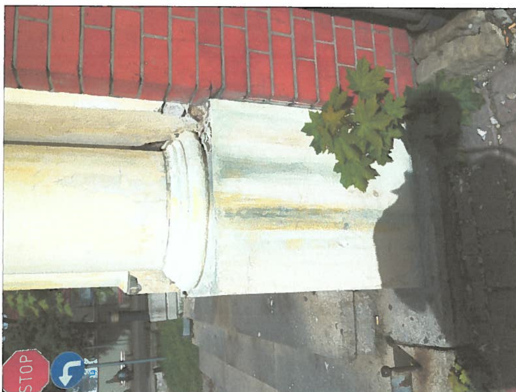
Fot. 4. Postument-silne zabrudzenia spowodowane spływaniem wody zadaszenia powyżej.
