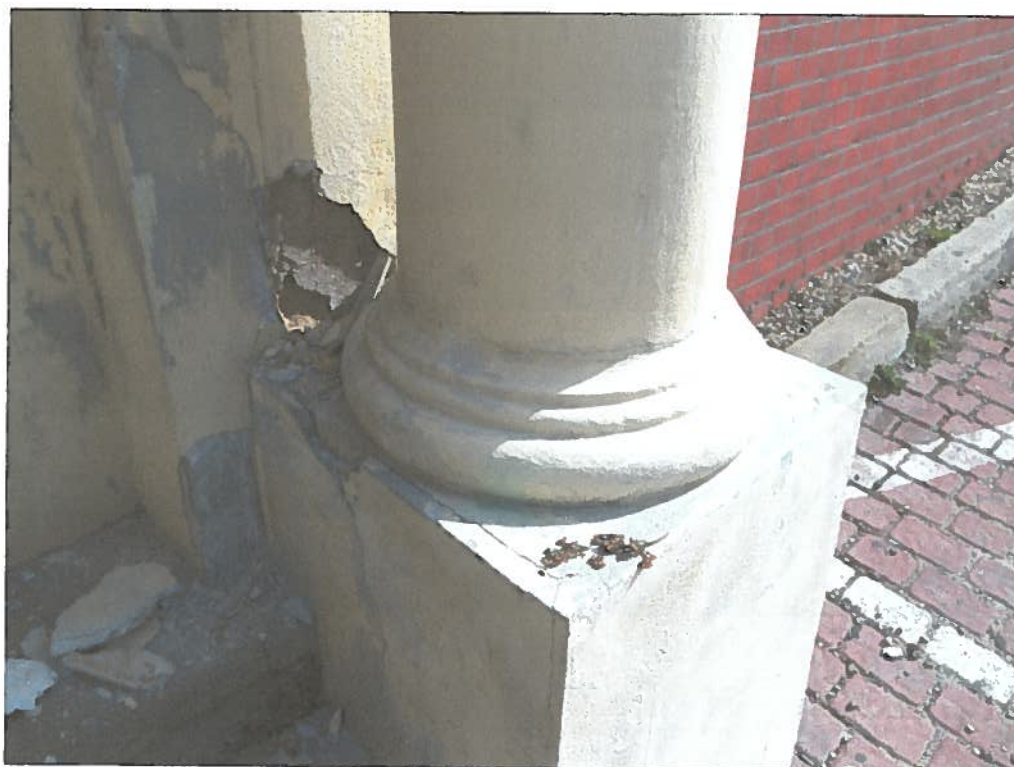
Fot. 10. Postument i baza kolumny. Widoczne liczne spękania tynku oraz pudrowanie farby.
