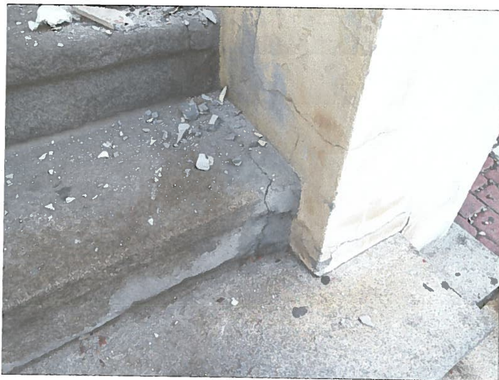
Fot. 13. Schody wejściowe. Liczne naprawy i uzupełnienia ubytków spoin.
