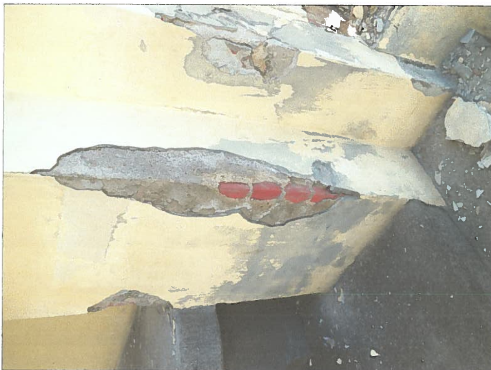
Fot. 3. Obramienie portalu-cegła elewacyjna, w tymie otynkowana.
