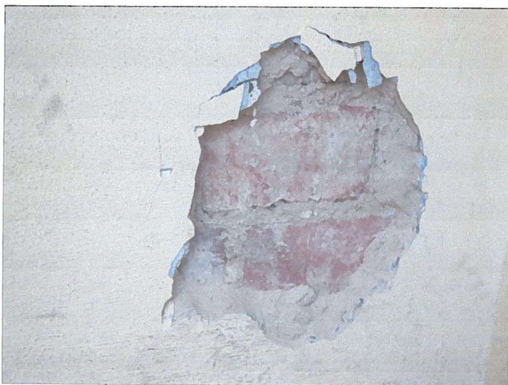
Fot. 6. W wnękach oraz przy drzwiach cegła budowlana
