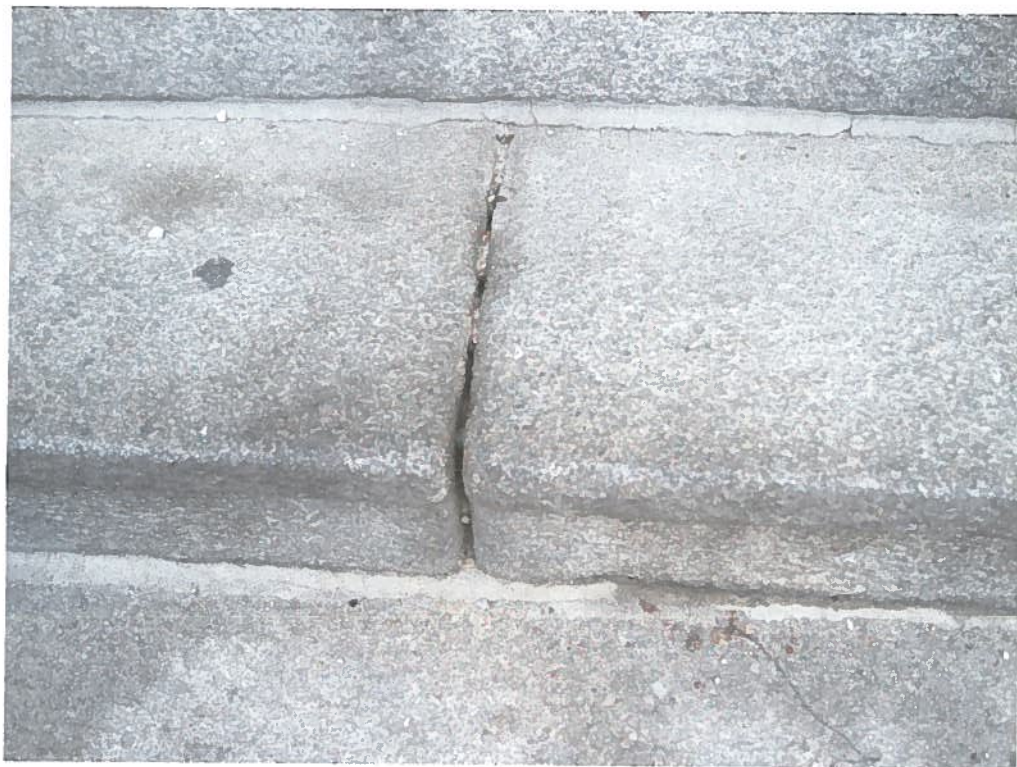
Fot. 11. Widok fragmentu schodów. Widoczne ubytki w fugach.
