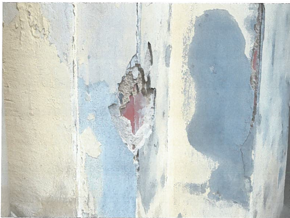
Fot. 5. Cegła elewacyjna, wtórnie otynkowana w obramieniu portalu
