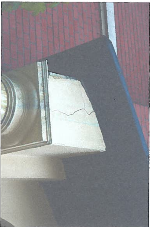
ZACIEKI NA KOLUMNACH Z POWODU BRAKU ORYNNOWANIA
