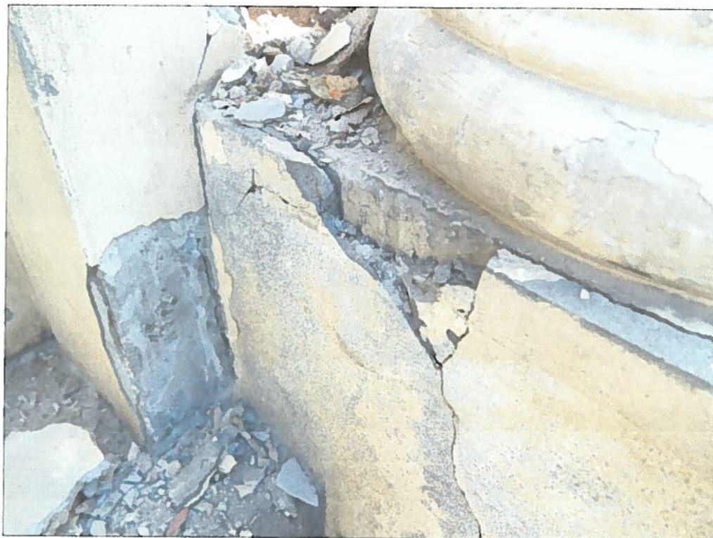
Fot. 9. Widok fragmentu postumentu. Odsłonięty oryginalny piaskowiec, wtórnje otynkowany
